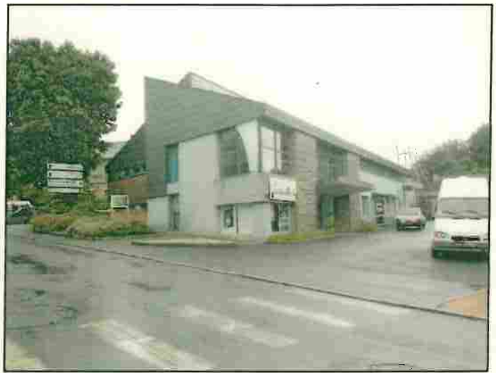
Vue du bâtiment de la route principale (actuelle)
